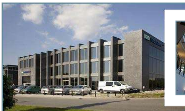
DB Telecom - Wieringen
